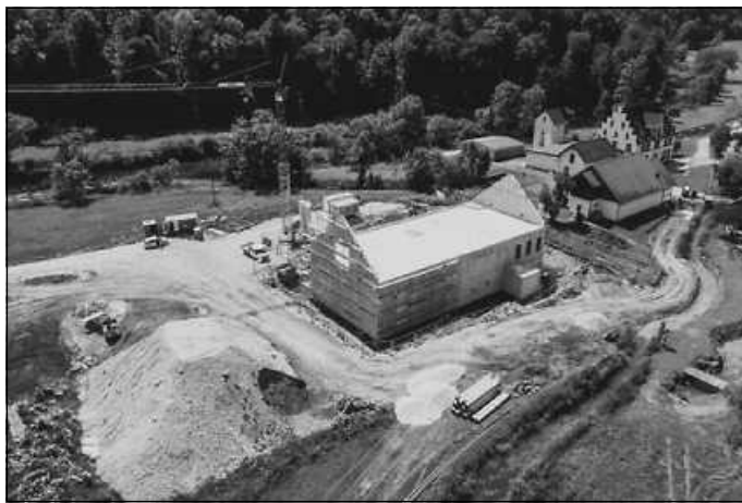
Luftaufnahme Neubau Wasserwerk Beuron-Langenbrunn Foto: Hohenberggruppe
